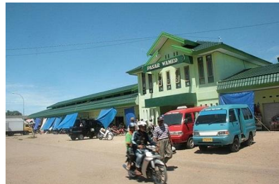
Gambar 3. Terminal Angkutan Umum di Pasar Wameo
