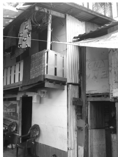
Gambar 3: Kondisi Luar Bangunan Pemukiman Sumber : Survey, 2015
